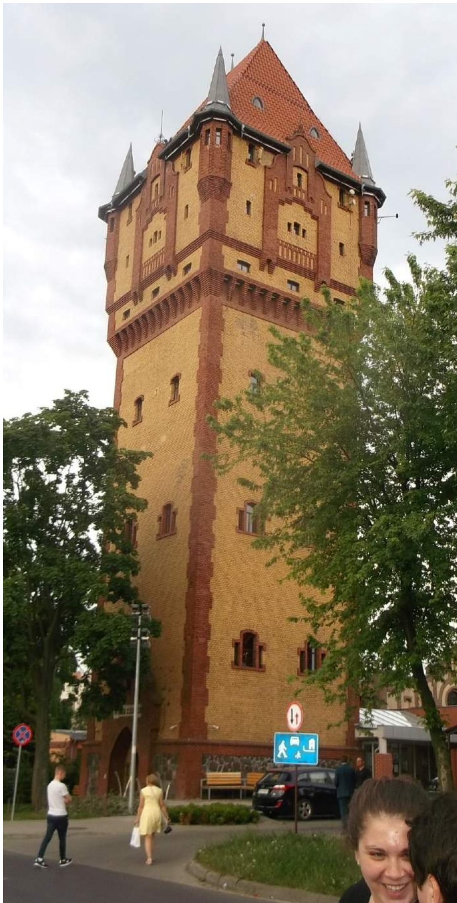
Kościń. Ciekawostką szczególną jest dostosowanie byłej wieży ciśnień do nowej funkcji, rekreacyjno-sportowo-edukacyjnej z nowoczesnym obserwatorium astronomicznym i obrotową częścią dachu o 360 stopni, i jedną z najwyższych w Polsce ścian wspinaczkowych (wys.18,3m, pow.200m 2 ).
