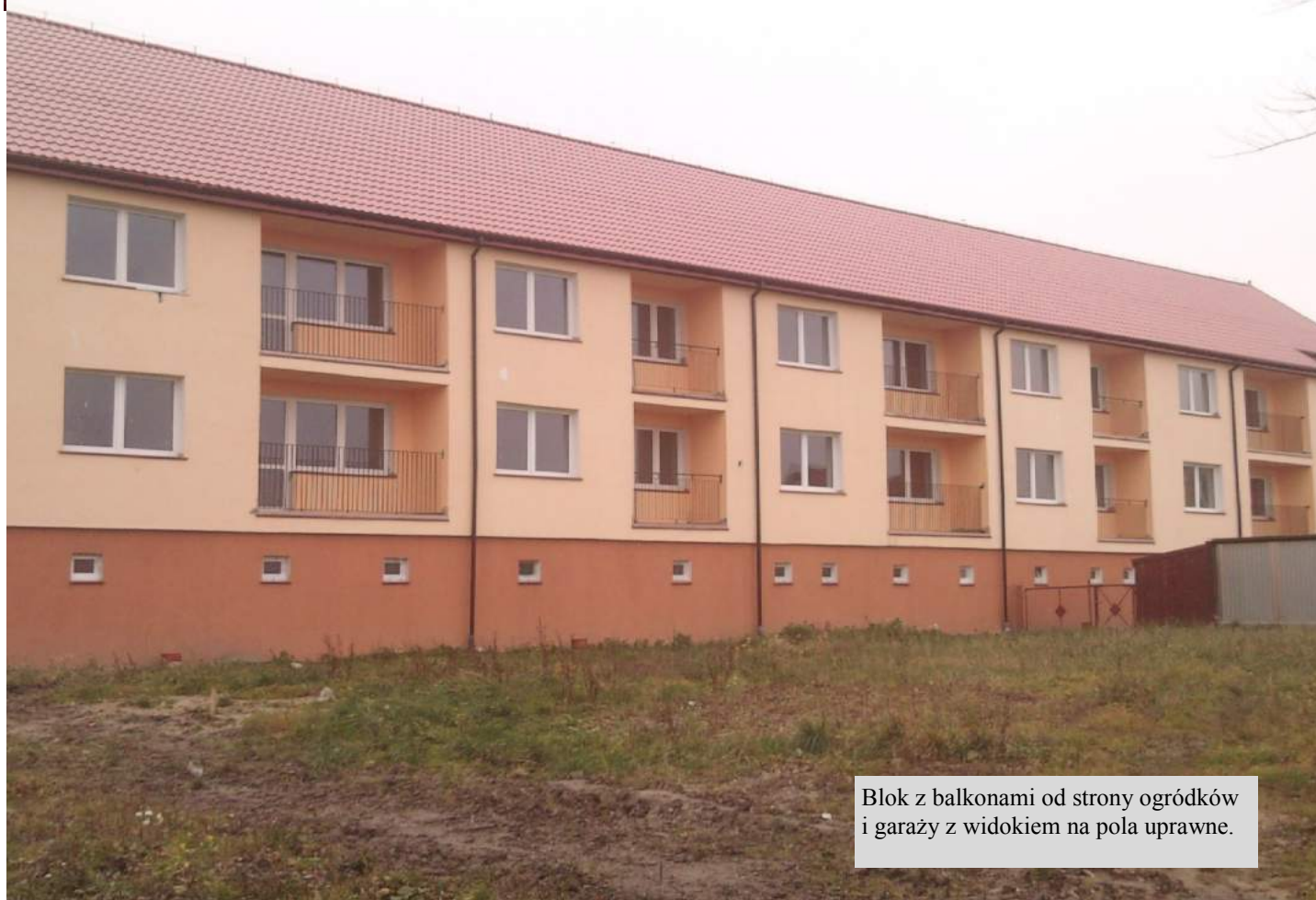
Strona frontowa od ulicy głównej. Przed blokiem przystanek autobusowy i przystanek sklepu mobilnego, oraz przystanek autobusu dla dzieci szkolnych, kaplica do nabożeństw ok.200m.
