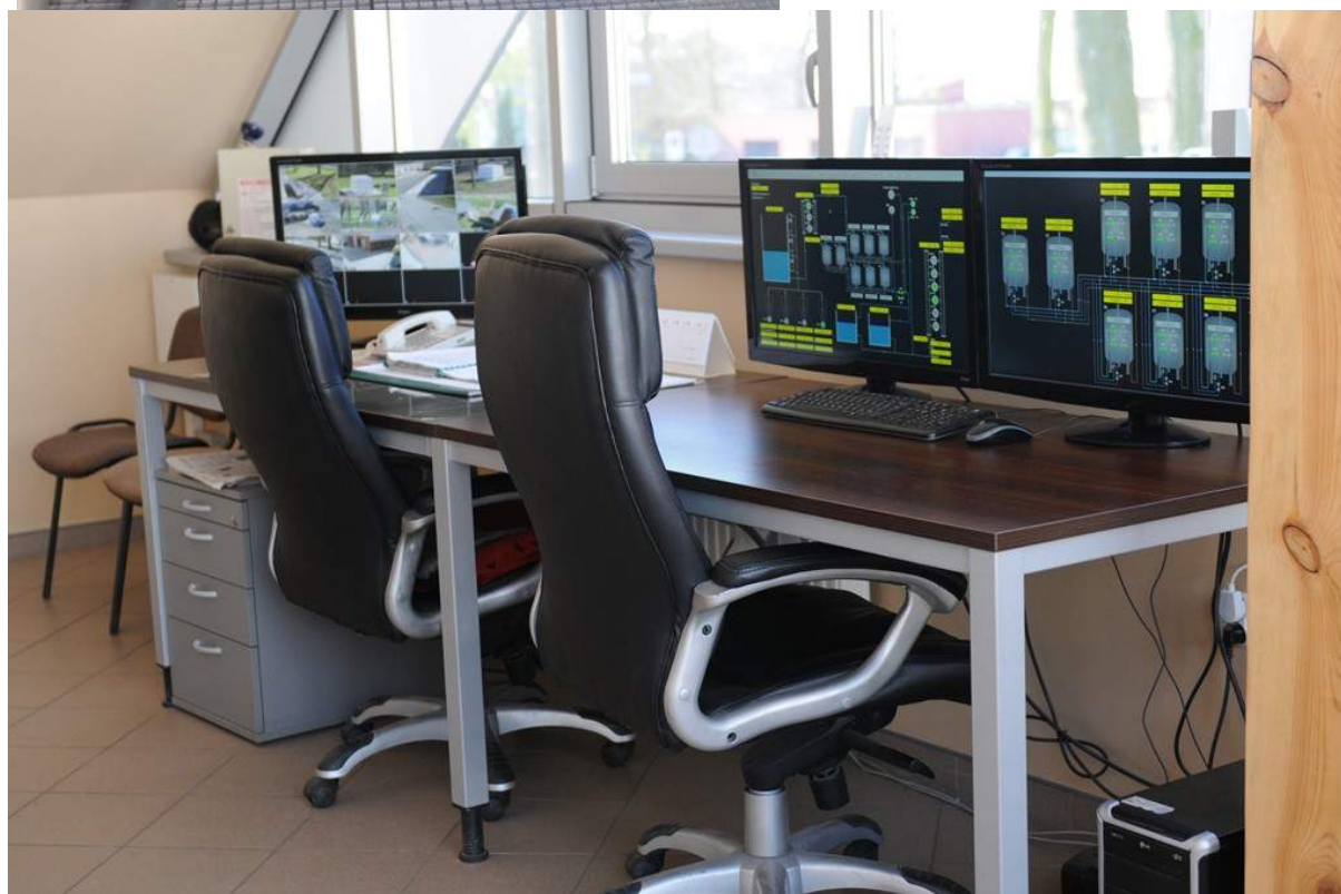
Dyspozytornia ze stanowiskiem sterownia i monitorowania procesu uzdatniania wody.
