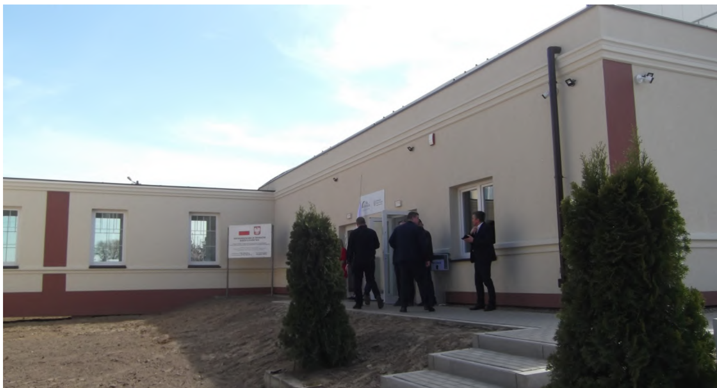
Wejście główne do nowo wybudowanej hali sportowej i łącznik łączący halę sportową z budynkiem Zespołu Szkół Lubraniec-Marysin.
