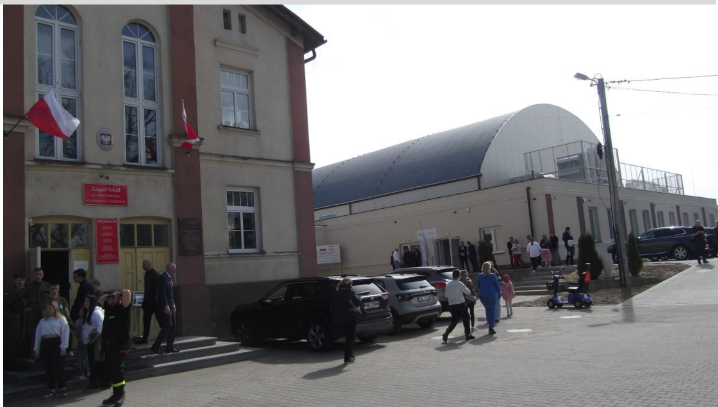
Wejście główne do budynku Zespołu Szkół w Lubrańcu-Marysinie. A na drugim planie nowo wybudowana hala sportowa.
